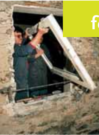
Ausbau von Altfenstern
